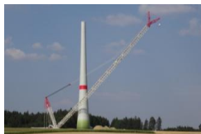
August 2015: fertiger Betonturm
