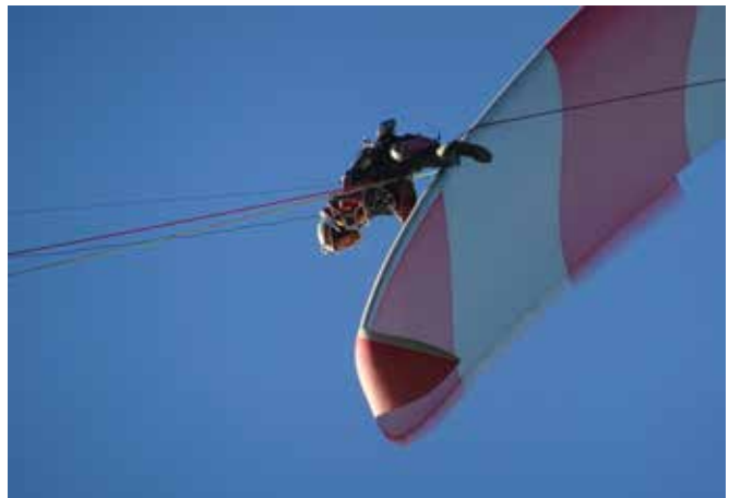
Turnusmäßige Flügelinspektion am Bürger-Windrad Kammerberg
