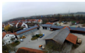
163 kWp Bürger-Solardach Bauhof Eching, 2018
