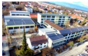
100 kWp Bürger-Solardach - Grund und Mittelschule Eching, 2013
