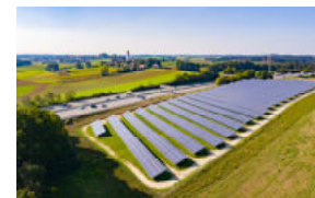
1.750 kWp Bürger-Solarpark Paunzhausen, 2020
