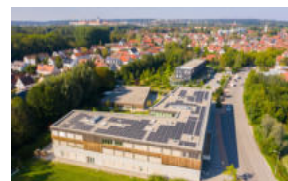
100 kWp Bürger-Solardach Montessorischule Freising, 2020
