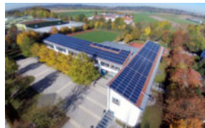
100 kWp Bürger-Solardach-Grundschule Eching, 2017
