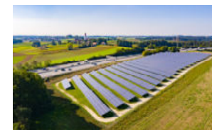
1.750 kWp Bürger-Solarpark Paunzhausen, 2020
