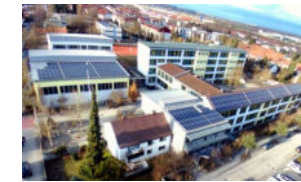
100 kWp Bürger-Solardach - Grund und Mittelschule Eching, 2013
