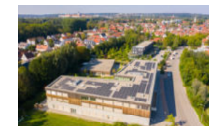
100 kWp Bürger-Solardach Montessorischule Freising, 2020
